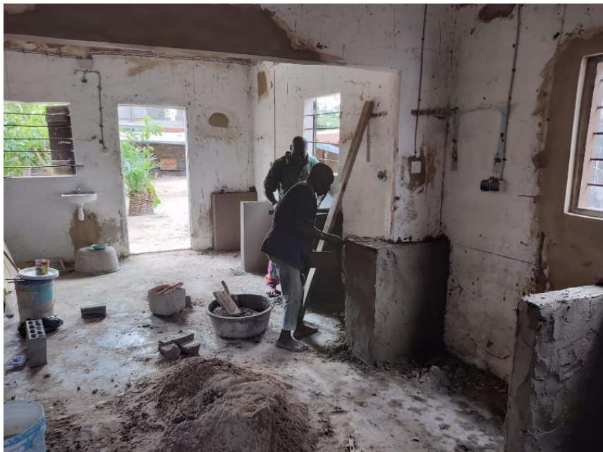
Arbeiten für die neue Werkstatt
