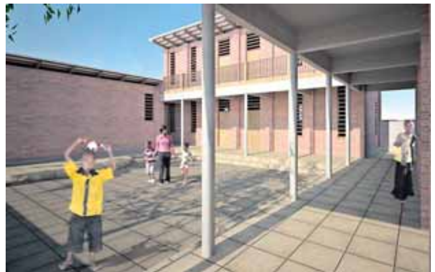
Der luftige Rohbau für 200 Schüler in Lomé steht. Architekt Kai von Döring freut sich über die Umsetzung seiner Pläne. Fotos: Schunk, privat
